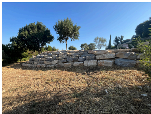
Enrochement parking rue sommière
