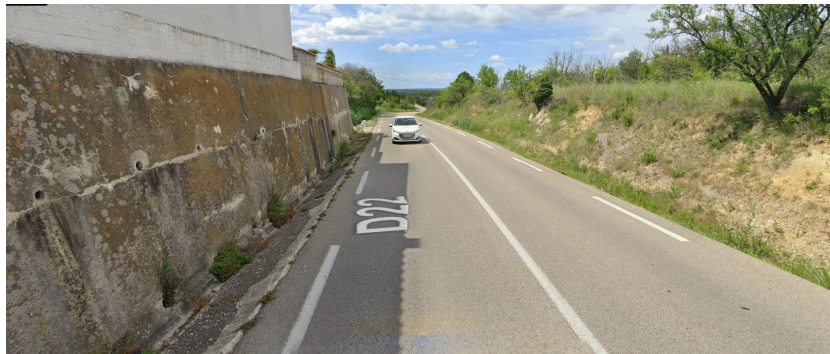
Vue de l'extension « Est » par le nord (RD22)
