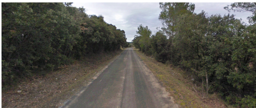
Vue de l'extension « Nord-Ouest » depuis la Perdigaille
