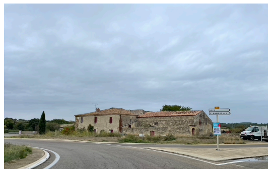
« La Baraque » au nord du village (ancien relais de la poste en cours de rénovation)
