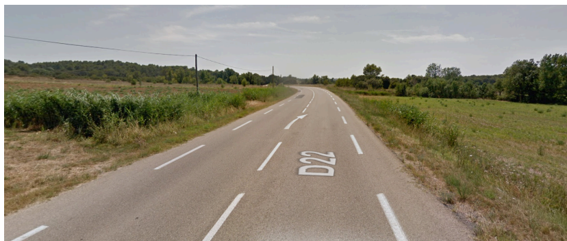
Vue de l'extension « Ouest » depuis la RD22 au sud de la commune
